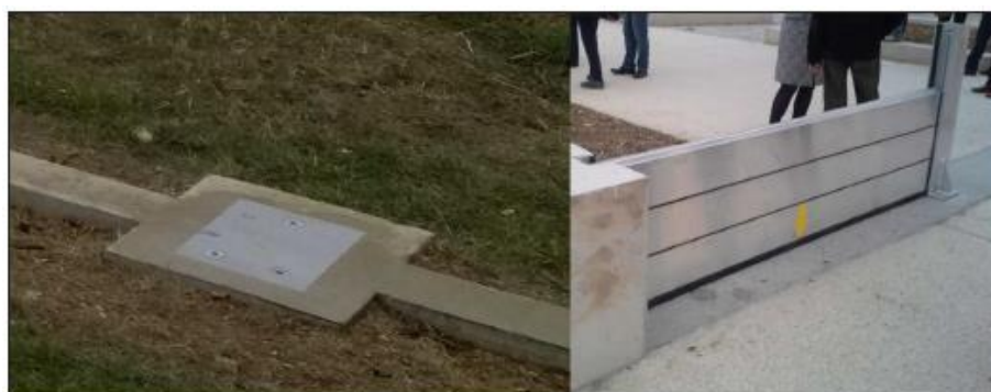
Vue de principe des protections amovibles sur le quai Jean Bart
